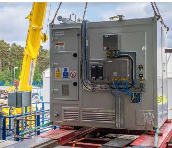
Zwei dieser Protonen-Austausch-Membran-Elektrolyseure (PEM) haben eine Leistung von 4 MW
