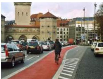
kung direkt und parallel zum geradeausführenden Kfz-Fahrstreifen bis an die Haltelinie geführt werden (Fotobeispiel München). Damit kann der sog. Konfliktpunkt soweit zurückverlegt werden, dass sich Radfahrer und Kraftfahrer bei mäßiger Geschwindigkeit gut sehen können. Der Radfahrer hat hier bei aller notwendigen Sorgfalt Vorrang vor dem seinen Fahrweg kreuzenden Kfz.
