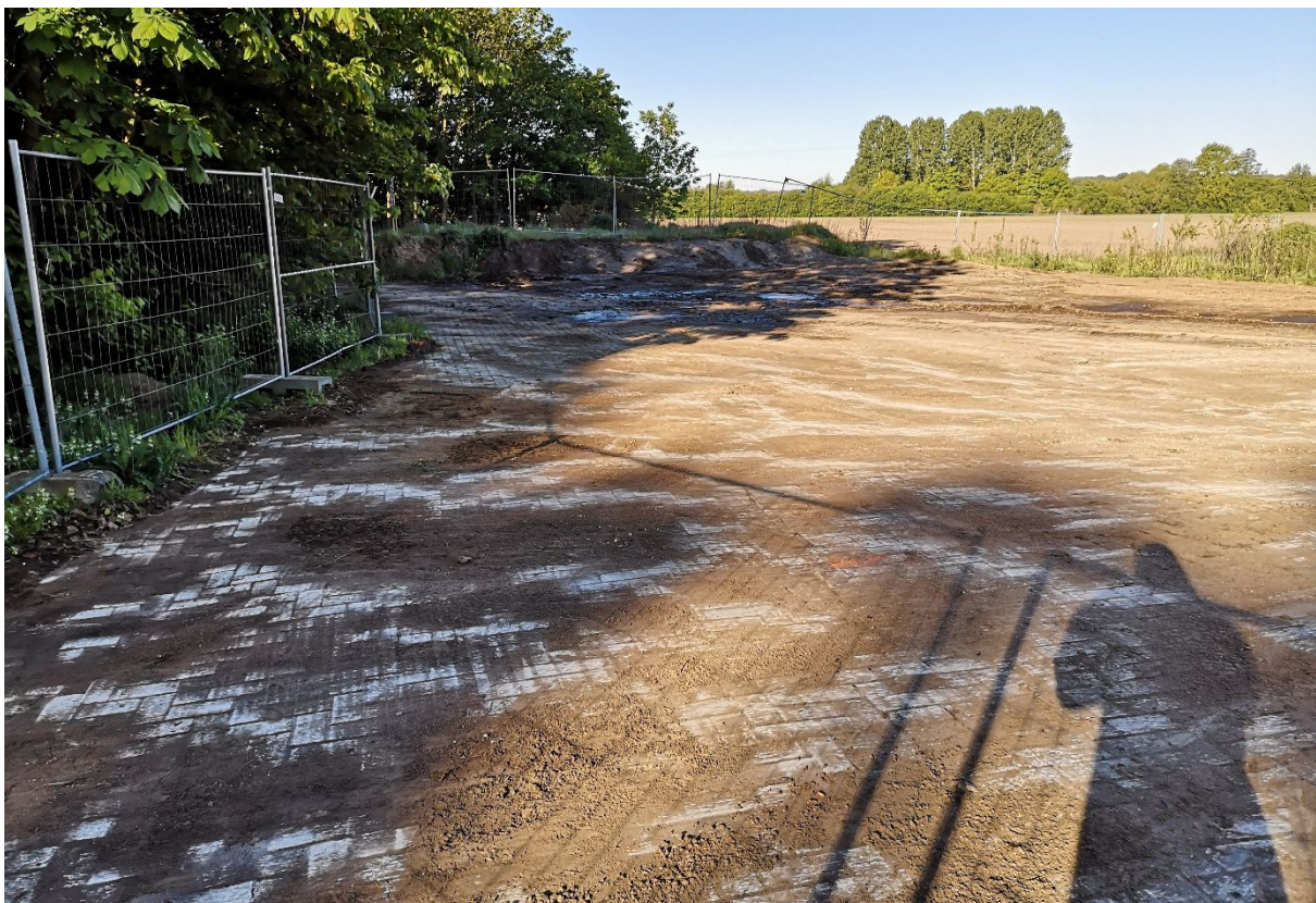
Abbildung 4: abgetragene Miete mit Betonpflaster unterhalb (Aufnahmedatum: 06.05.2020).
