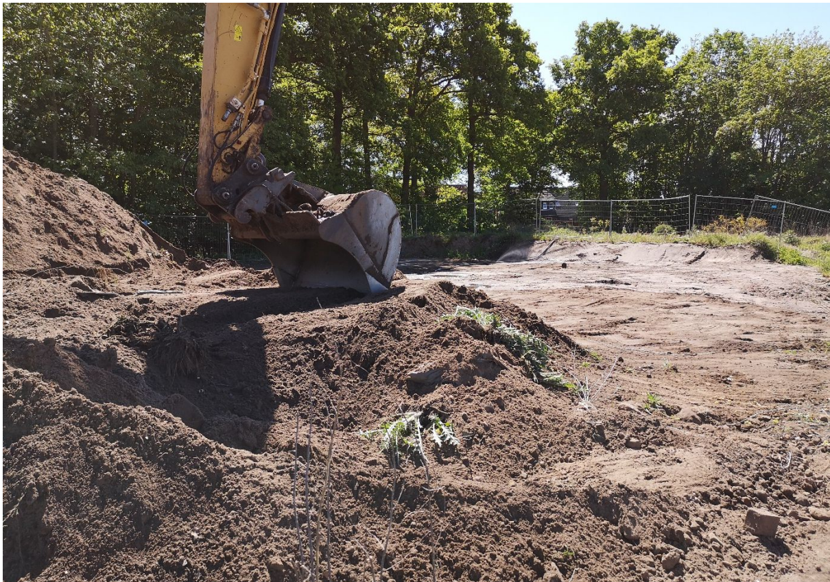
Abbildung 3: Abtrag der Miete bis auf gewachsenen Boden bzw. Betonsteinpflaster (Aufnahmedatum: 05.05.2020).
