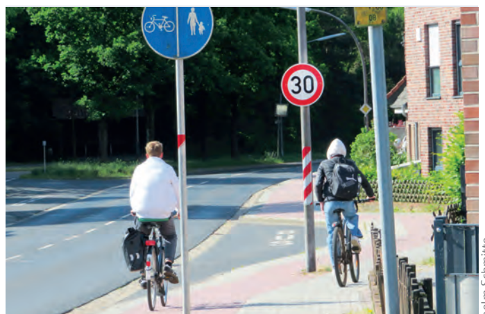
Nicht ungefährlich ist der Radweg entlang der Kiesbergstraße nahe der Einmündung Drei Berge.
