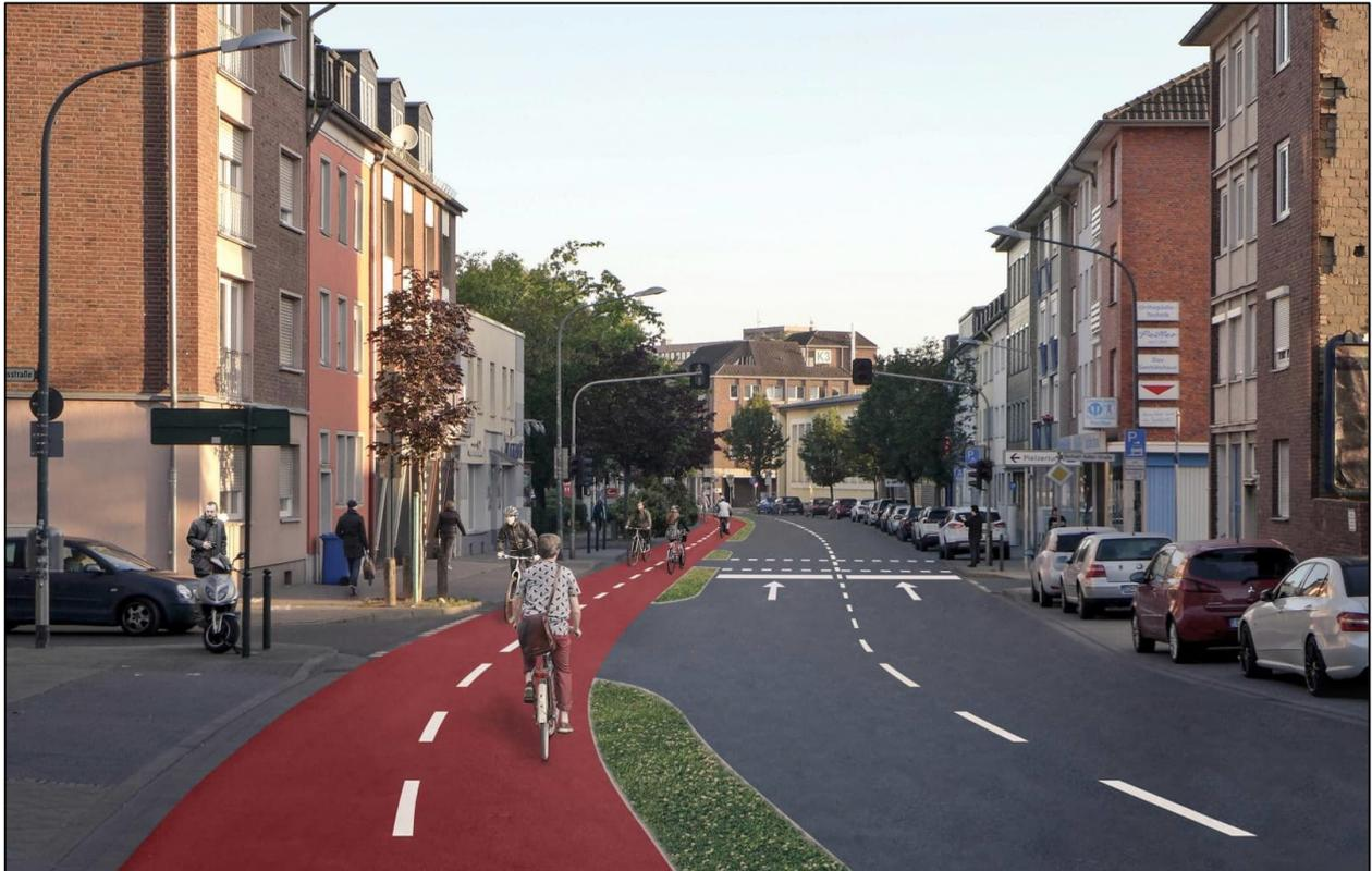
Abbildung 5: Düren, Innenstadtring - Einrichtungsring mit Zweirichtungsradweg
