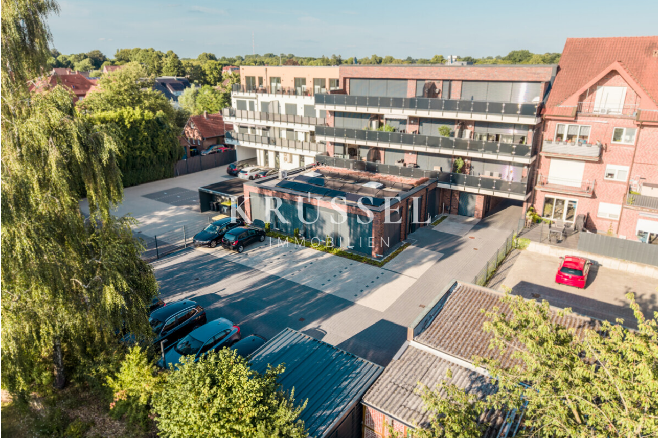
Der Innenhof mit Stellplatzmöglichkeiten
