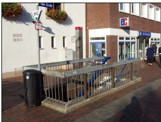
Abb. 5: Zwar funktional und technisch in Ordnung – dennoch könnten die Treppenabgänge zur Tiefgarage unter Lingens „guter Stube“ modernisiert und ansprechender gestaltet werden
